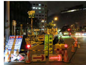
繁華街エリアでの工事 (大阪：ターミナル駅周辺)
