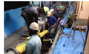
繁華街エリアでの工事 (京都：店舗密集地域)
