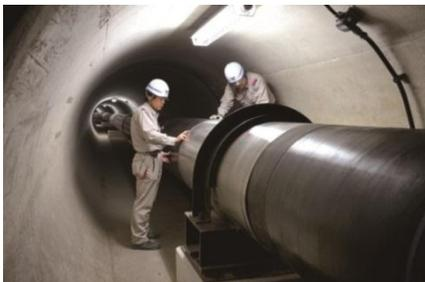
ピグ検査：ガスの供給を継続している状態で、流れているガスの差圧で管内を検査装置（ピグ）を走行させ、管内清掃や内径測定その他、管体の減肉や管体への接触物を検知します。
